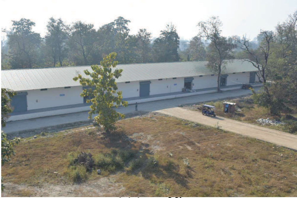
एम.पी.डी.डी. का नवनिर्मित भवन
